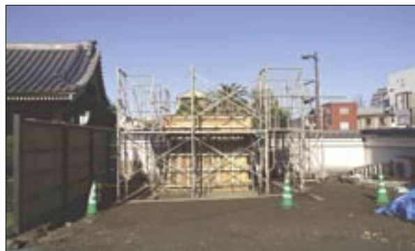
台座工事中 2月29日現在
